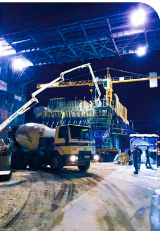
Concretagem do bloco de ancoragem (7000 m 3 ), em várias etapas, da Ponte Hercílio Luz, em Florianópolis (início de 2019)
