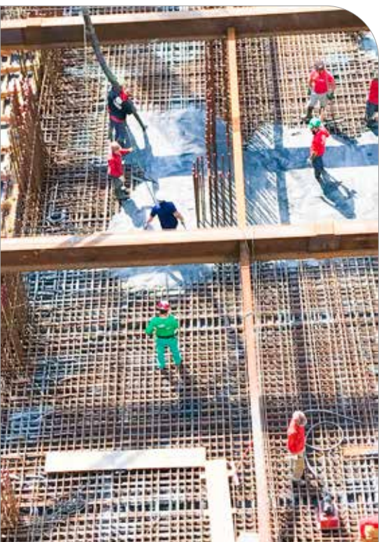
Vista superior de concretagem do bloco do Edifício Vitra (alta taxa de armadura exigiu uso do CAA)
